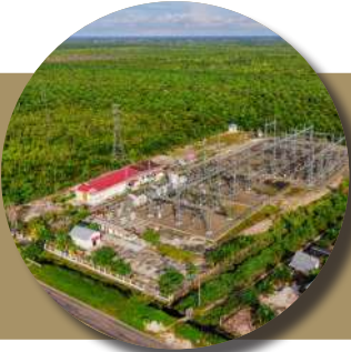
Pembangkit Listrik Power Plant
